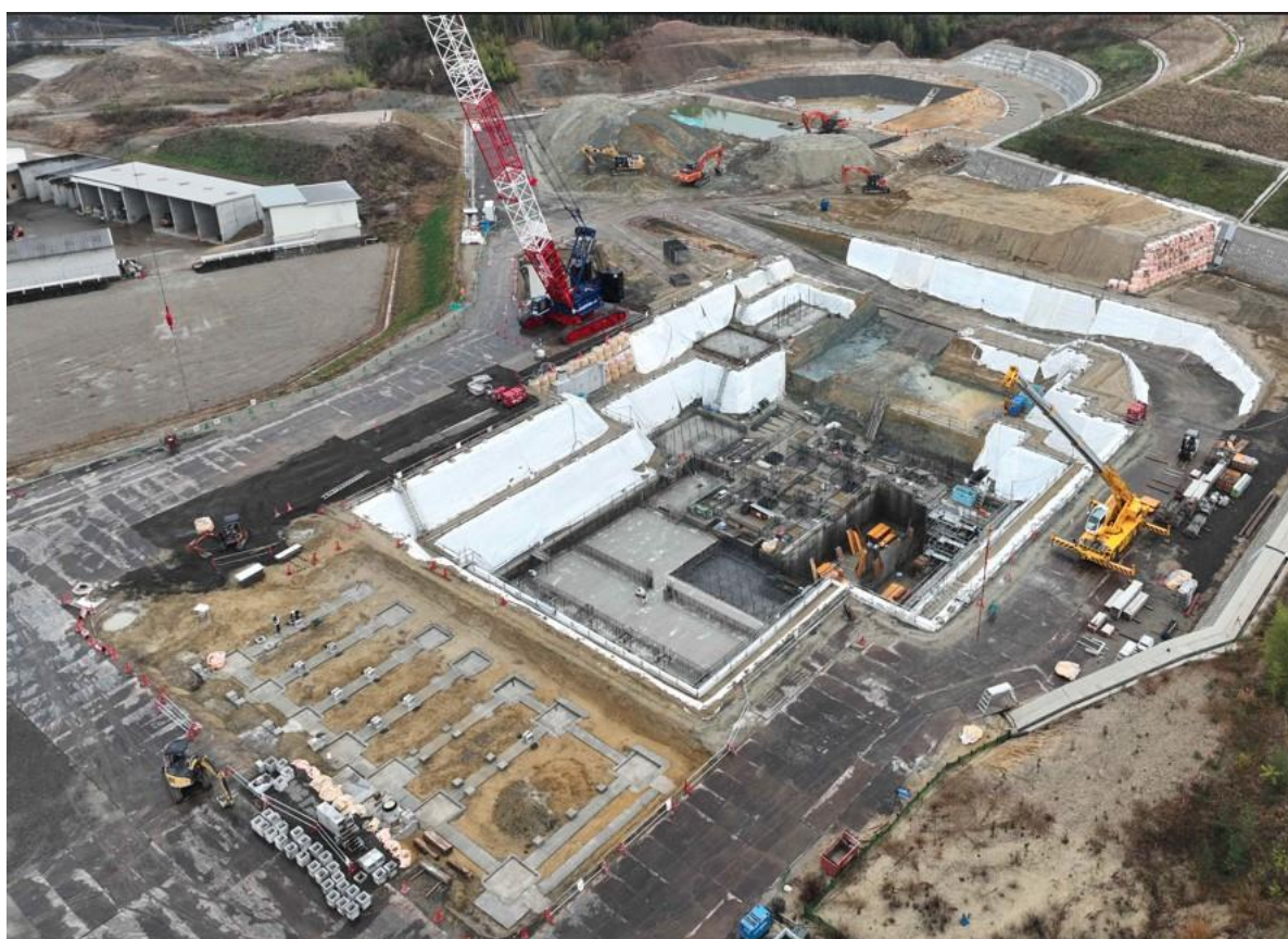
現況写真・工場棟工事施工の様子（令和5年12月15日時点）
